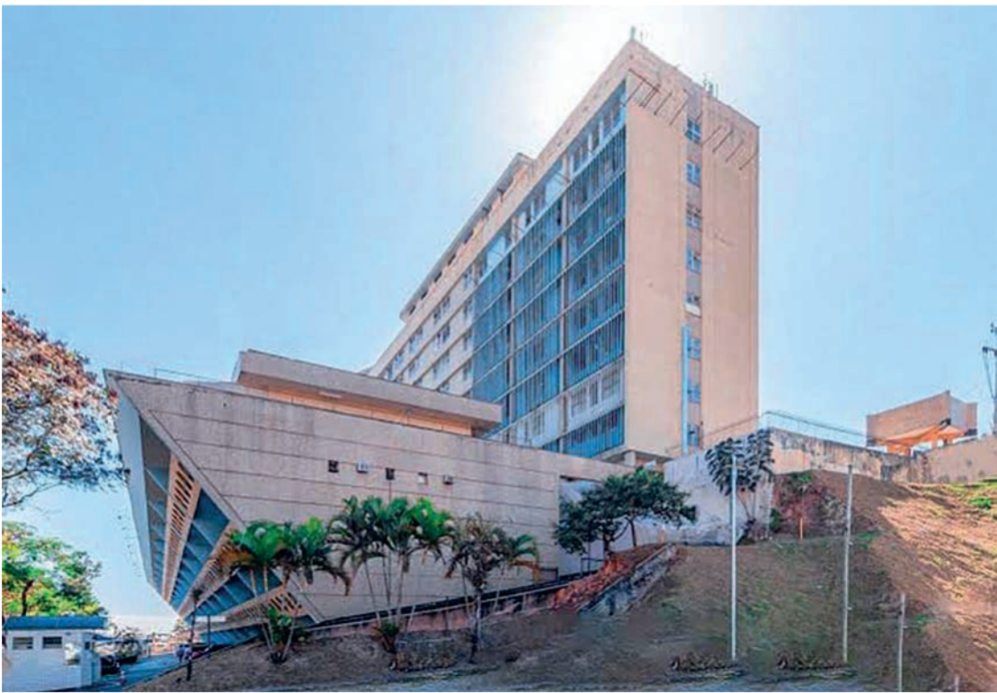
Hospital Belo Horizonte está com Pronto Atendimento suspenso desde o mês de julho FOTO: DIVULGAÇÃO / HOSPITAL BELO HORIZONTE
